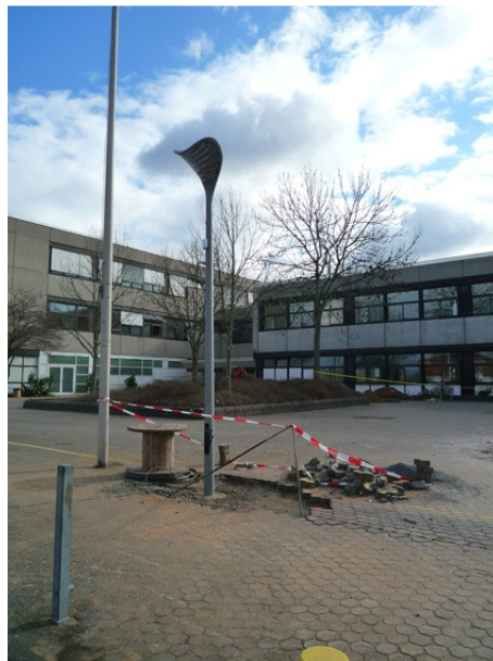
Montierte LED Leuchte auf Mast
