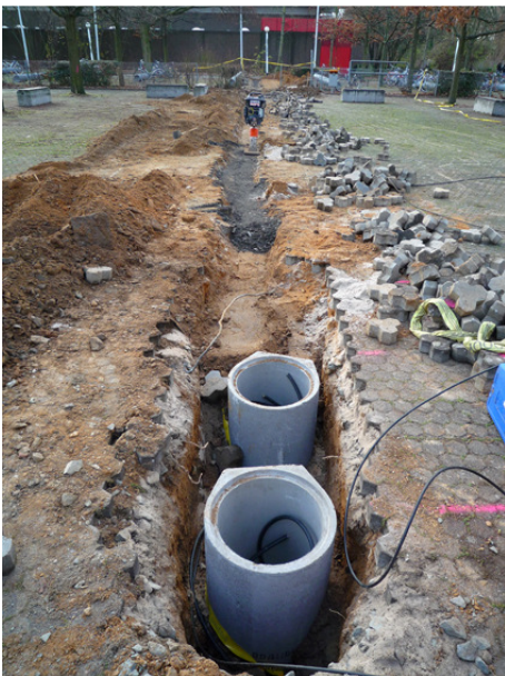
Leerrohre für Betonfundamente zur Maststellung
